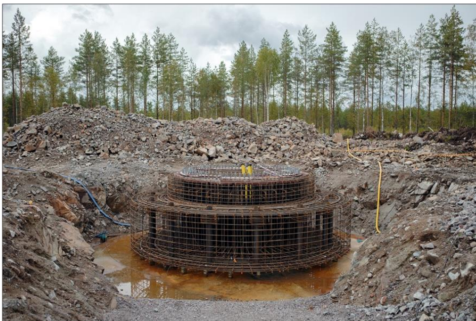
Kuva 6-3. Maanvarainen teräsbetoniperustus raudoitettuna ennen betonivalua.
