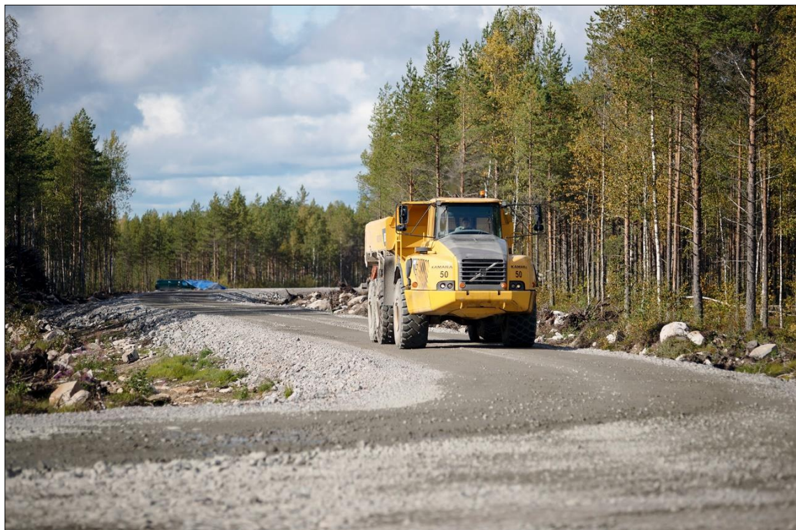
Kuva 6-7. Esimerkkikuva tuulipuiston rakenteilla olevasta huoltotiestä (kuva: OX2).
