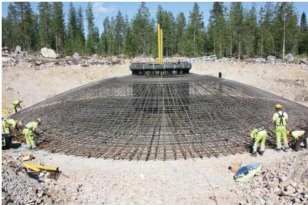
Kuva 6-3. Maanvarainen teräsbetoniperustus raudoitettuna ennen betonivalua.
