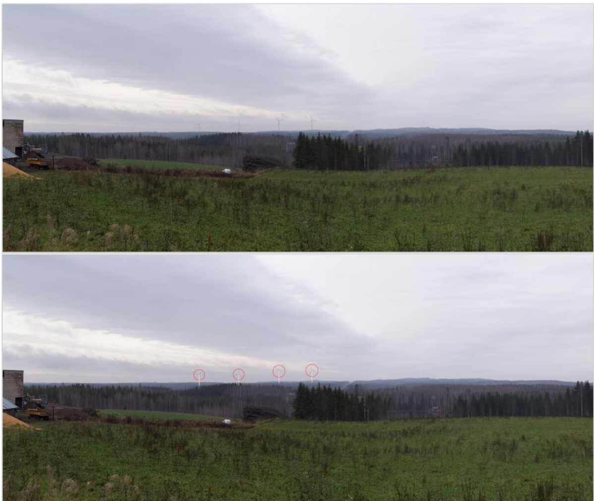
Kuva 9-5. Kaavaratkaisun mukaiset tuulivoimalat Kortemäeltä katsottuna pohjoisen suuntaan (kuvauspiste 2). Olemassa oleva voimajohtoaueka näkyy tuulipuiston oikealla puolella. Etäisyys lähimpiin voimaloihin on noin 5,7 km. Havainnollisuuden vuoksi voimalat on esitetty alemmassa kuvassa ns. rautalankamallina.
